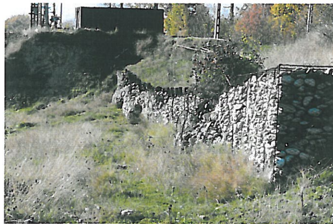
Sprijiniri din gabioane pentru protectia drumului
