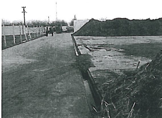
Canalul colector și direcționare lichide / Bazinul vidanjabil de colectare lichide
