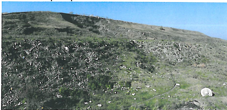
Fenomene de eroziune pe halda de steril / cenusa
